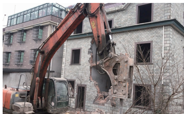
图为征拆现场
